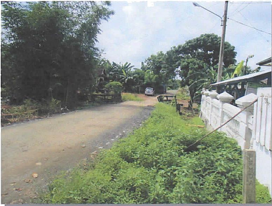
Gambar 9. Akses Jalan Ke Pasar Hewan Sarang Halang
